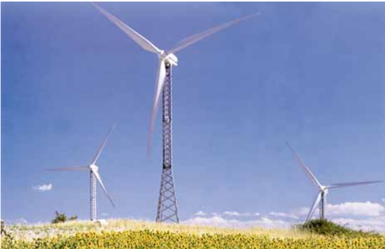
Impianto eolico di Volturara Appula (FG)
