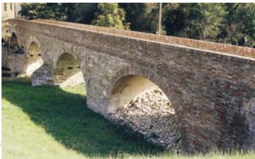
Il ponte a 5 arcate che unisce le sponde del fiume Chienti in località Pontelatrate. Costruito nel XIV secolo è stato recentemente restaurato
