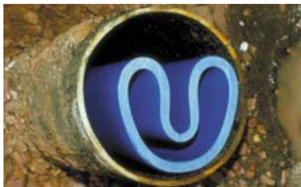
Inserzione di tubi in PEAD a sezione deformata che viene successivamente riportata a sezione originale con conseguente perfetta adesione alle pareti
