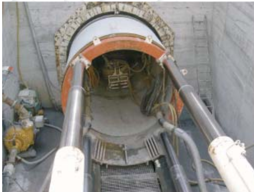
Perforazione orizzontale per la posa di tubazioni idonee alla spinta con la tecnica del microtunneling
