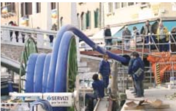
Rinnovamento di condotta esistente tramite inserzione di tubi in PEAD
