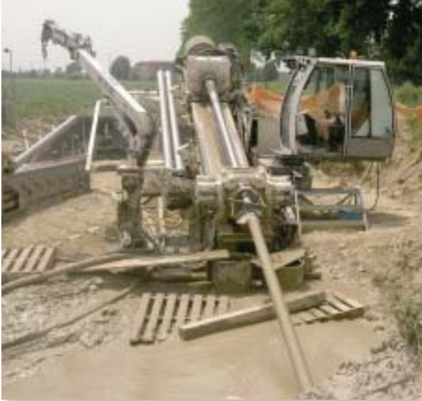
Perforazione per posa in opera di nuove condotte
