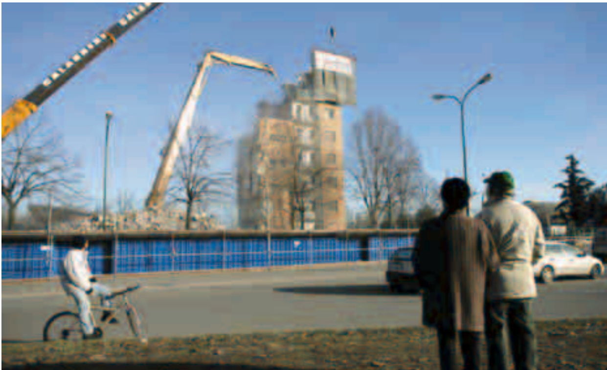
Demolizione con ganasce di un palazzo nel Comune di Torino
