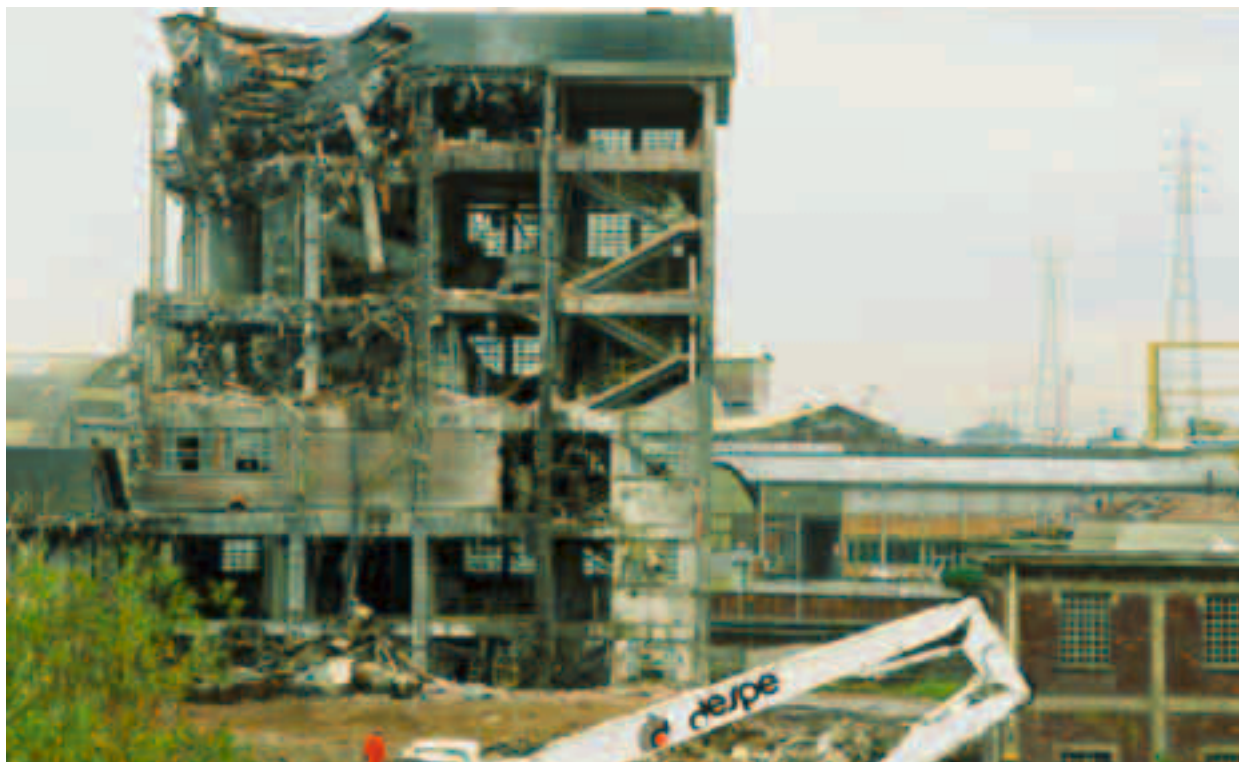
Demolizione a Marghera
