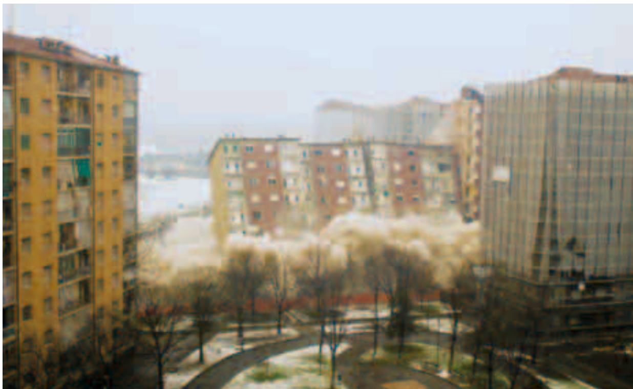
Demolizione con esplosivo di un palazzo nel Comune di Torino
